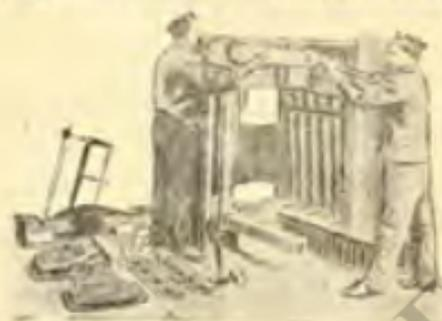
Фиг. 132. Сборка большого секционного котла.
