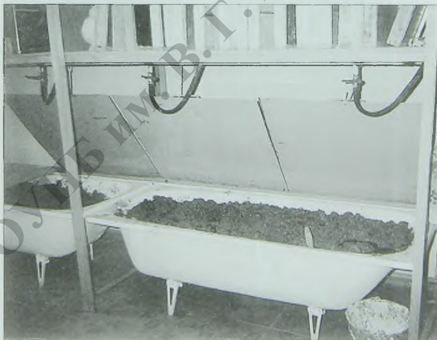
Установка ванн под глину
