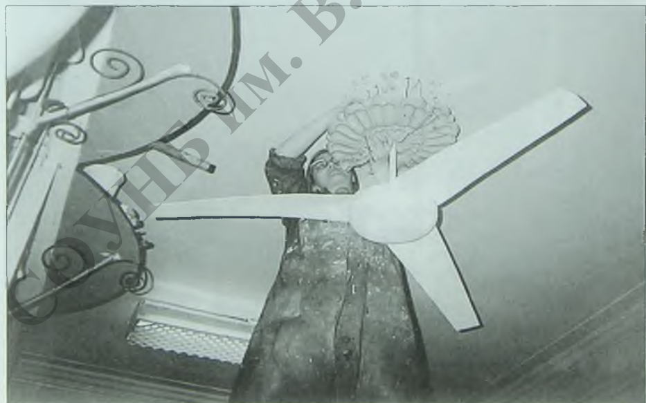
Установка розетки на потолке мастерской
