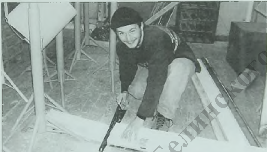
Заготовка переплетов окон
