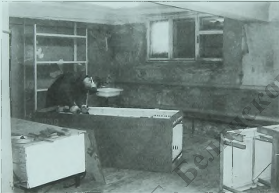
Резка газосваркой металлических шкафов, август 2007 г.
