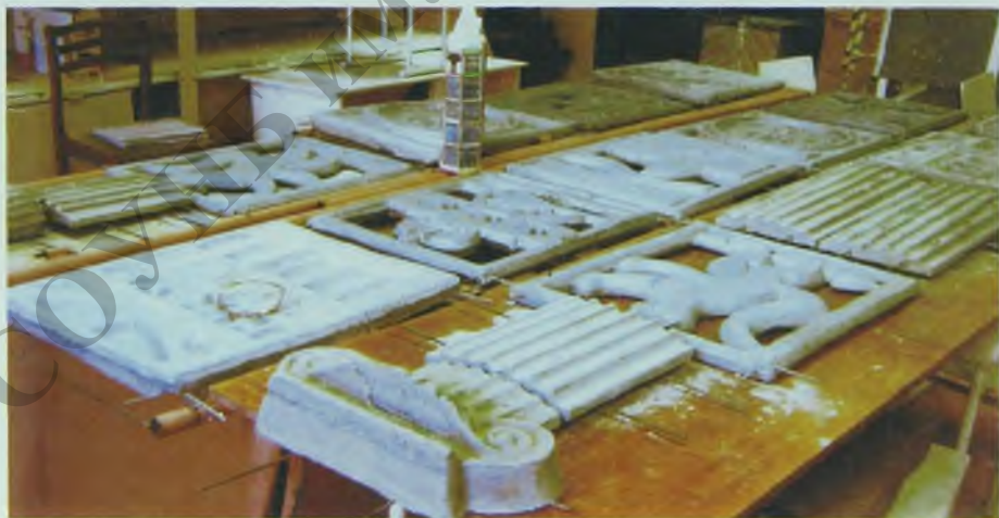
Рельефы на «исходной» позиции для монтажа
