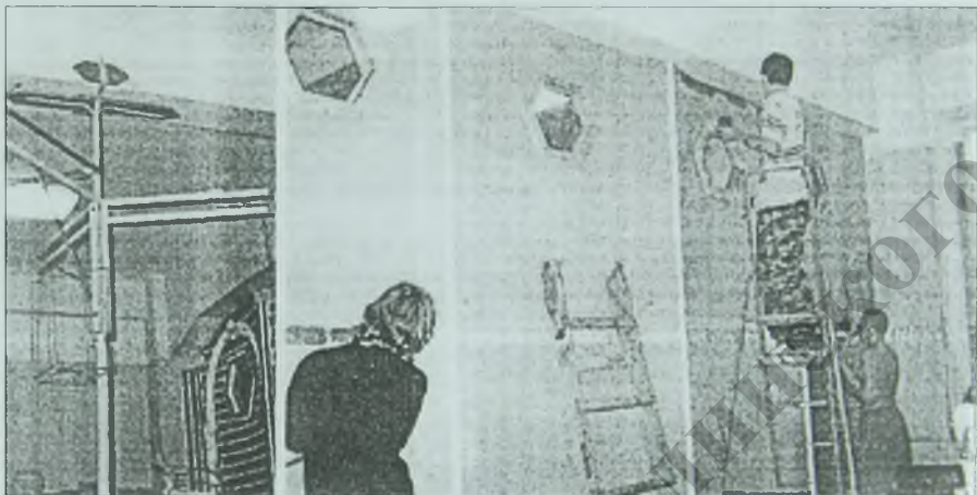
Стенка закрыта листами ДВП и начата роспись под кирпич. Установлены шестигранные окна. Лето 2003 г.
