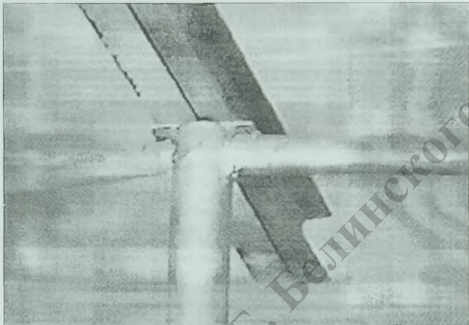
Крепление 2-х тавровой балки на стойке (сварка)
