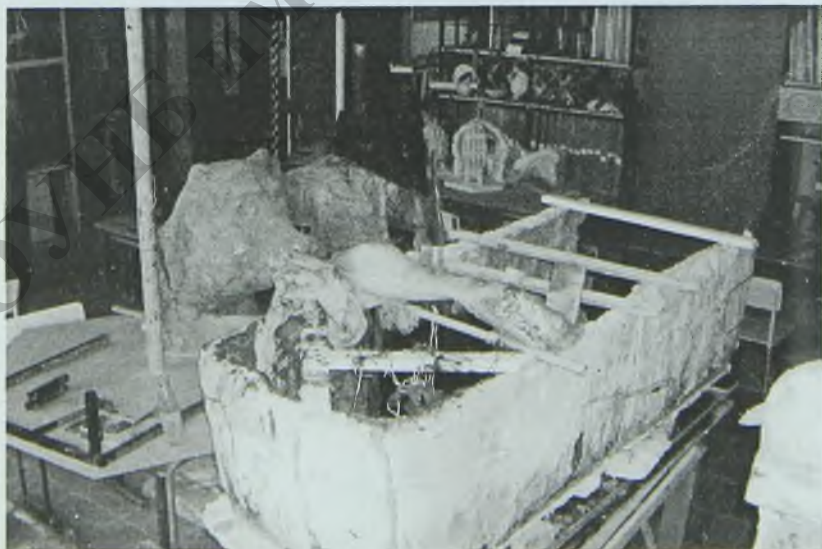
Кусковая форма с туловища готова для заливки бетоном
