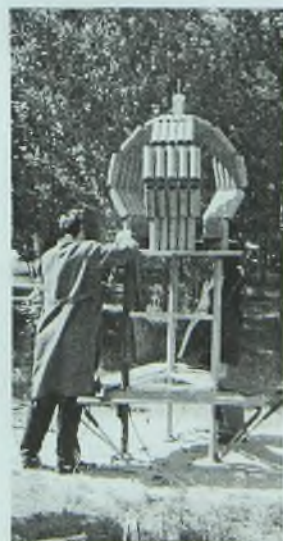
Сварка составных частей
