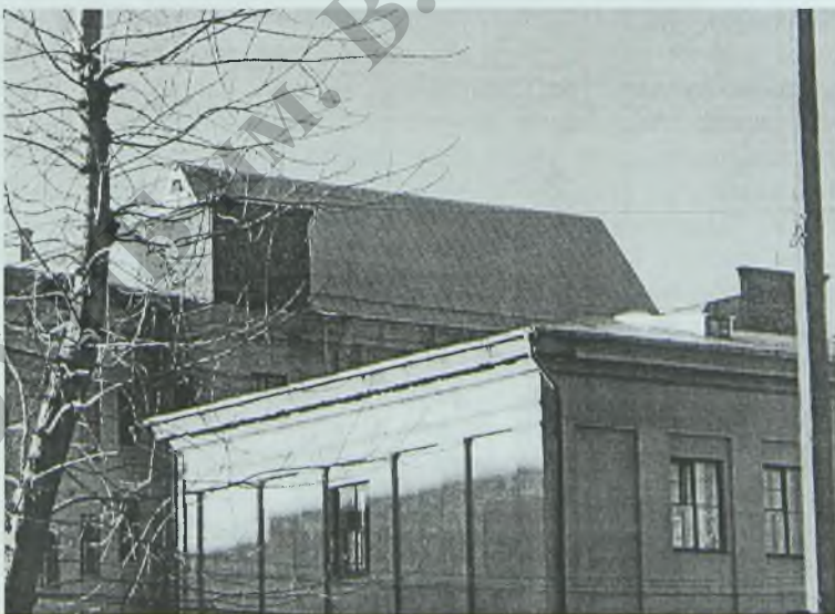
Фонарь обладает большим резервом аудиторного фонда Фонарь задуман автором здания – архитектором Бабыкиным К.Т. для верхнего освещения
