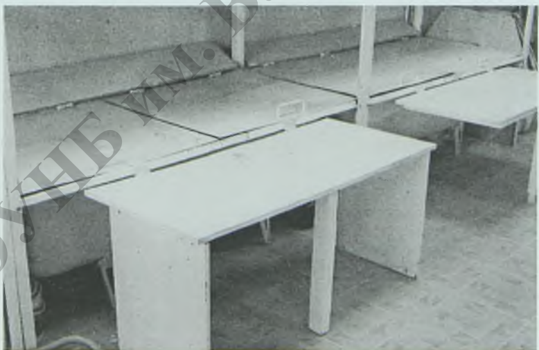
Кроме того, столы используются для работы над эскизами и картонами. В сложенном положении боковые опоры под- гибаются и столешница повисает на шарнирах. Средняя опора «уходит» под ванну в горизонтальном положении.
