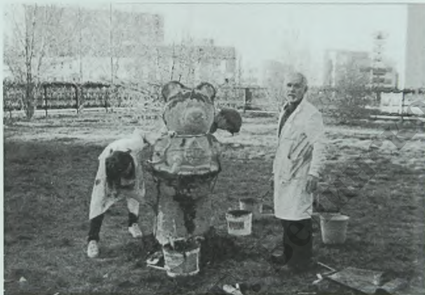
Монтаж «Мишки олимпийского» на фундаменте в парке института. Май 2009 г.
