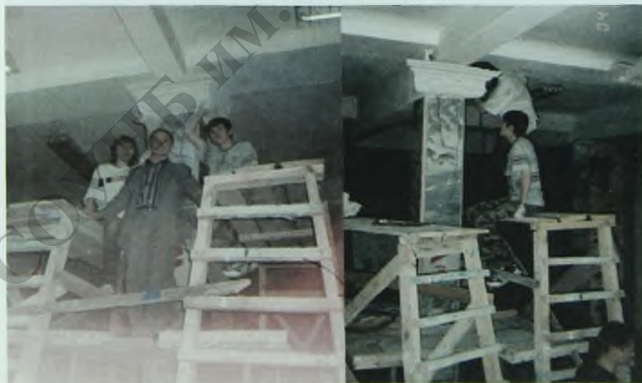
Установка карниза и ионической капители на колонне 3-го этажа строительного факультета. Студенты Поляков П., Коновалов О., рук. Постоногов Ю. И.
