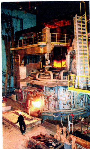
Электросталеплавильная печь. Фото из архива пресс-службы СТЗ.
