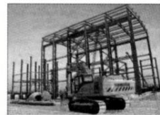
Февраль 2011 года – начальная стадия строительства завода по производству молотого мрамора.
