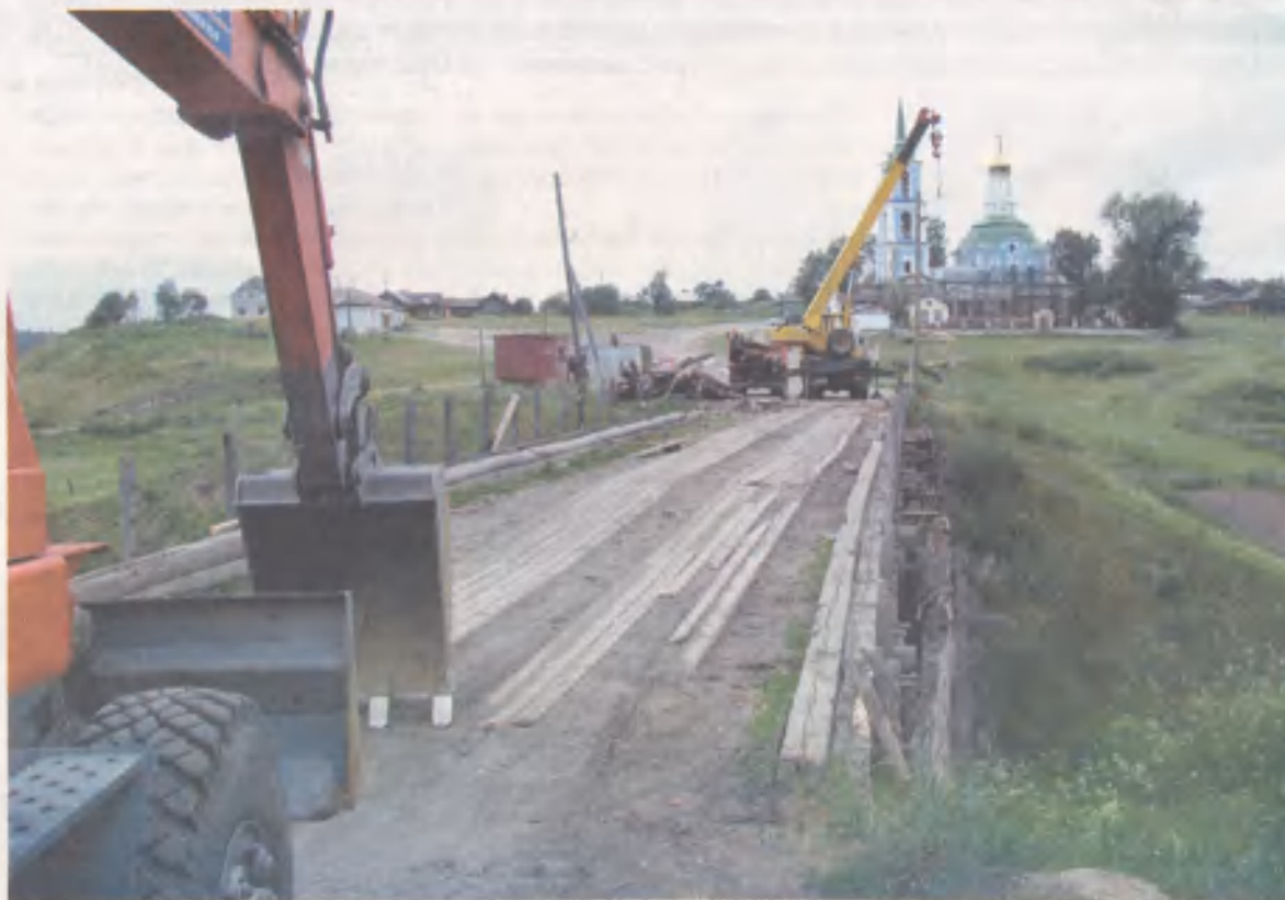
В Нейво-Шайтанском начато строительство нового моста
