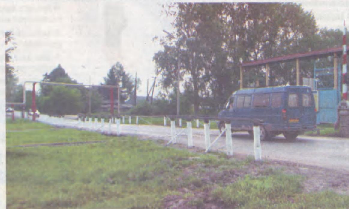
Отремонтирован железнодорожный переезд в микрорайоне ДОКа
