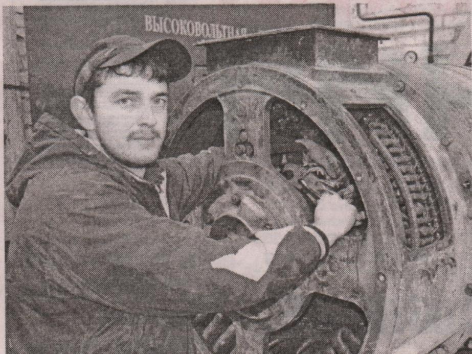
Ремонт генератора синхронного тягового БелАЗа выполняет Сергей ДЕДЮХИН, испытатель электрических машин и приборов.
