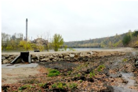
Новая дорога к плотине
