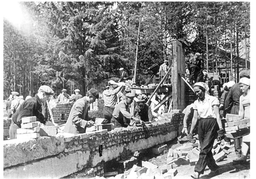
Комсомольский субботник на строительстве корпуса в пионерском лагере «Факел», 1966 г.
