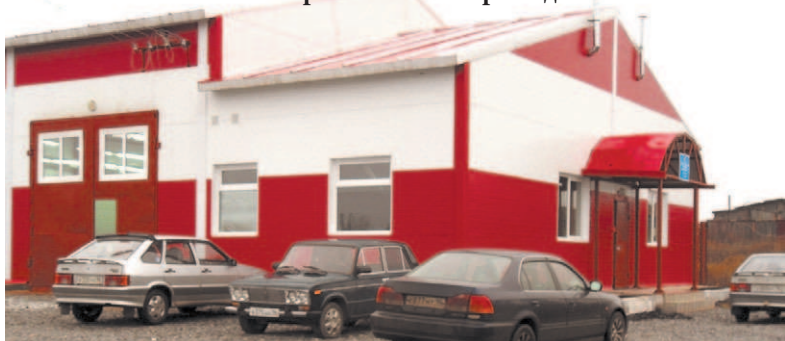
Современное пожарное депо в Н. Синячихе
