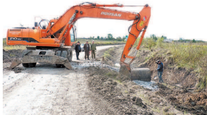
Ремонт дороги в с. Фоминском
