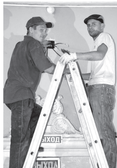
Михаил Бучин (слева) и Сергей Квасов выполняют электромонтажные работы
