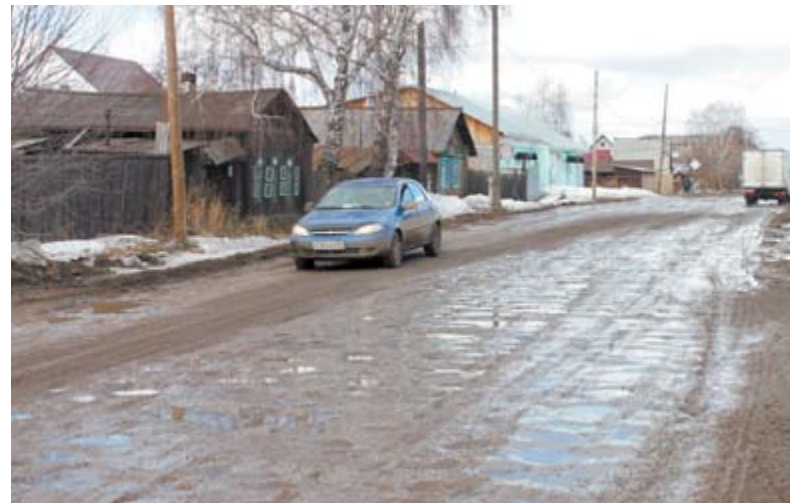
...в отличие от улицы Глухих, которая не является центральной или транзитной, - контракт на ремонт дороги уже заключен
