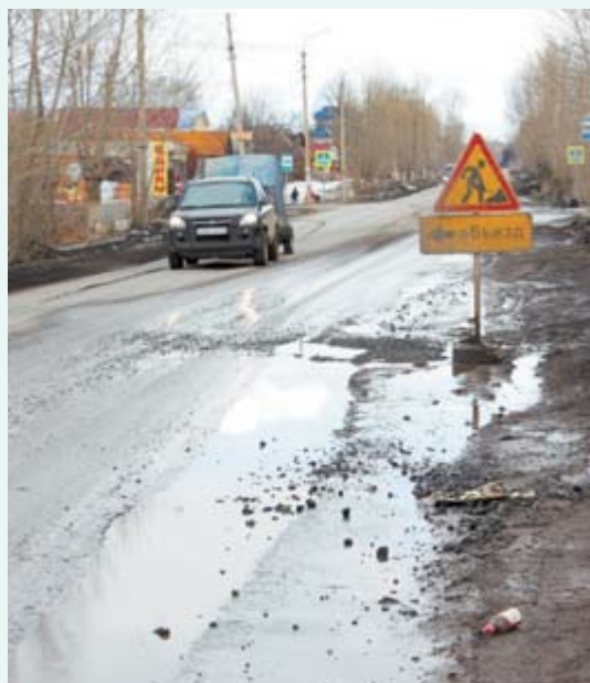
В этой яме на ул. Николая Островского пробито не одно автомобильное колесо. Знаки «Объезд» и «Ремонтные работы» появились только в начале недели
