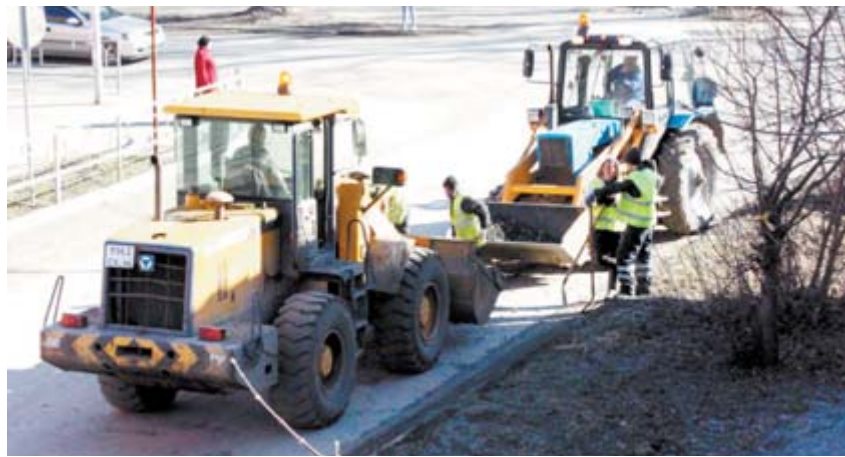
Ямочный ремонт на ул. Софьи Перовской завершили до Дня Победы
