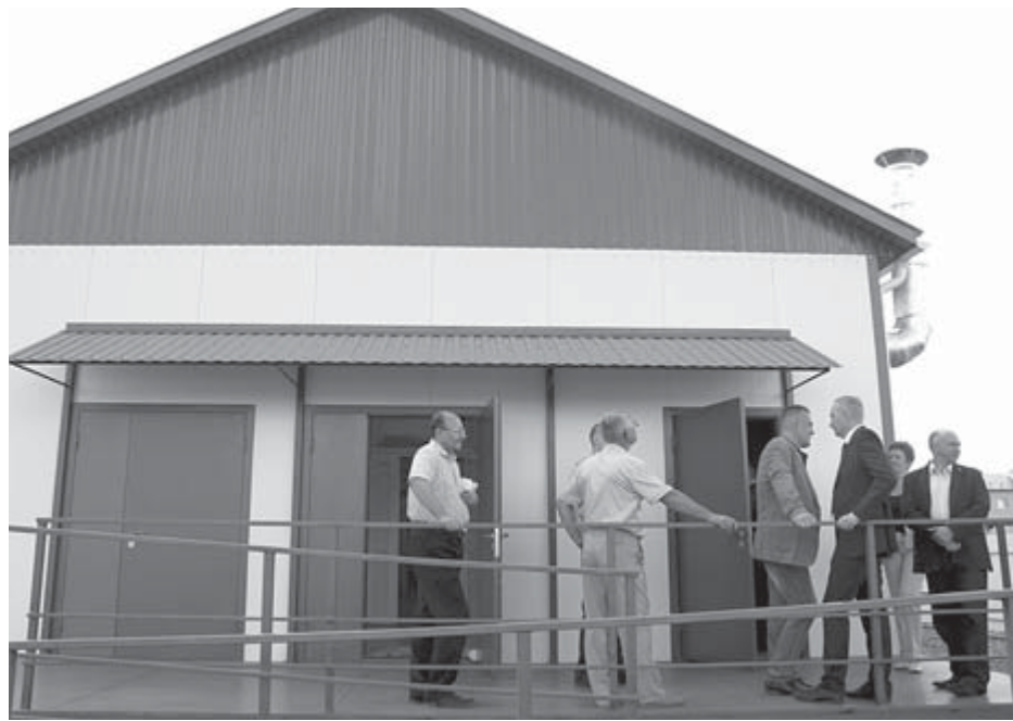
Новое здание морга расположилось рядом с ЦГБ
