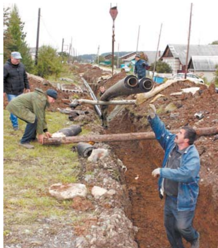
В поселке Западном заканчивают замену труб теплотрассы на ул. Юбилейной
