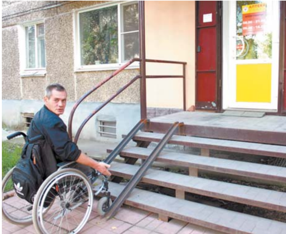
На такой пандус заехать не получится. Угол наклона завышен, а значит опасен для подъёма
