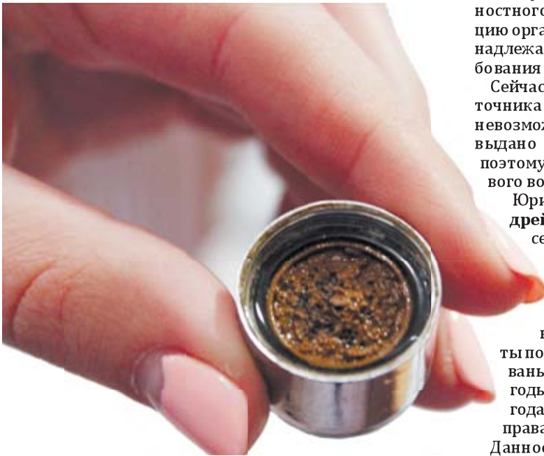
Фильтры на водопроводных кранах забиваются грязью
