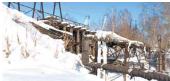
Перед плотиной находится теплотрасса, которую нужно будет временно убрать
