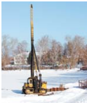
Сваебой установлен на верхнем бьефе
