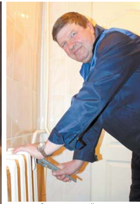
Слесарь аварийно-восстановительных работ Сергей Жуков
