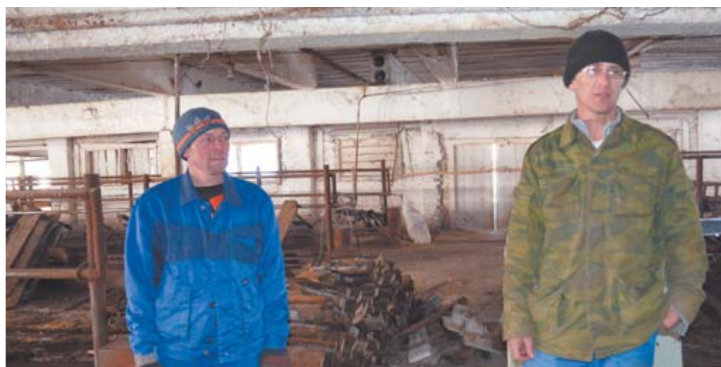
Верхнеярская ферма. Александр Немытов (справа) и Павел Жарков ведут демонтажные работы
