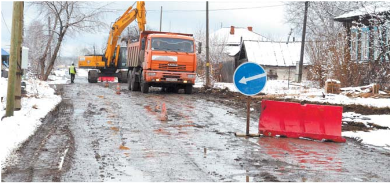
Участок дороги по ул.Гоголя от ул.Ленина до ул.Колногорова
