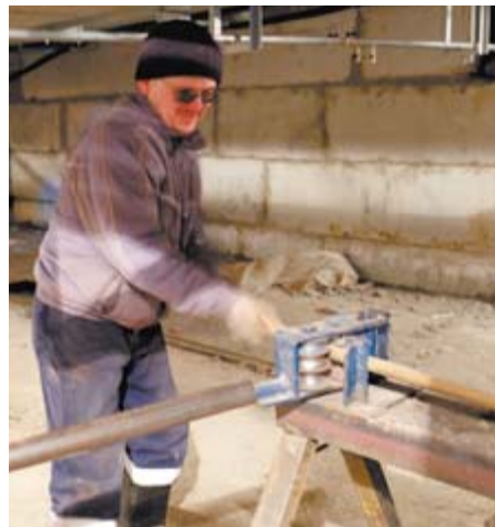
Монтажник субподрядной организации ООО «Премиум-строй» Денис Татаринов на гибочном станке выполняет загиб трубы для системы отопления
