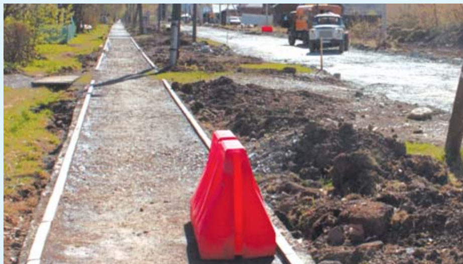
На улице Перминова готовятся к укладке асфальтобетона.
