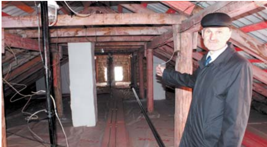
Александр Онучин на чердаке дома № 2 по ул. Городок Карьера
