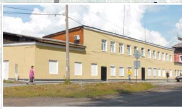
Впервые в связи с Царскими днями отремонтирован фасад здания аварийной службы и единой диспетчерской службы по улице Ленина
