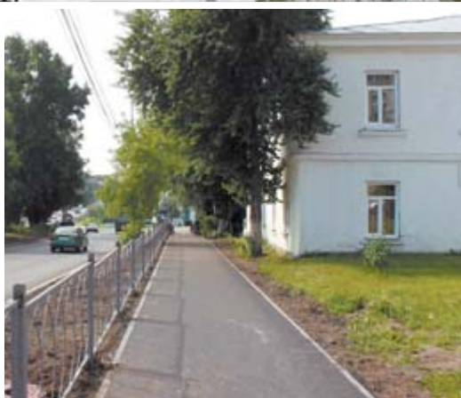
На улице Ленина от Соборной площади до улицы Папанинцев заменено асфальтовое полотно на дороге, тротуарах, сделаны ограждения. Продолжается замена столбов уличного освещения
