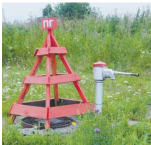
Пожарные гидранты огорожены вот такими пирамидами
