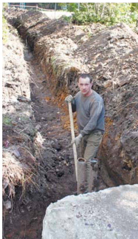
Юрий Томилин, слесарь по ремонту тепловых сетей и оборудования МП «Энерготепло»
