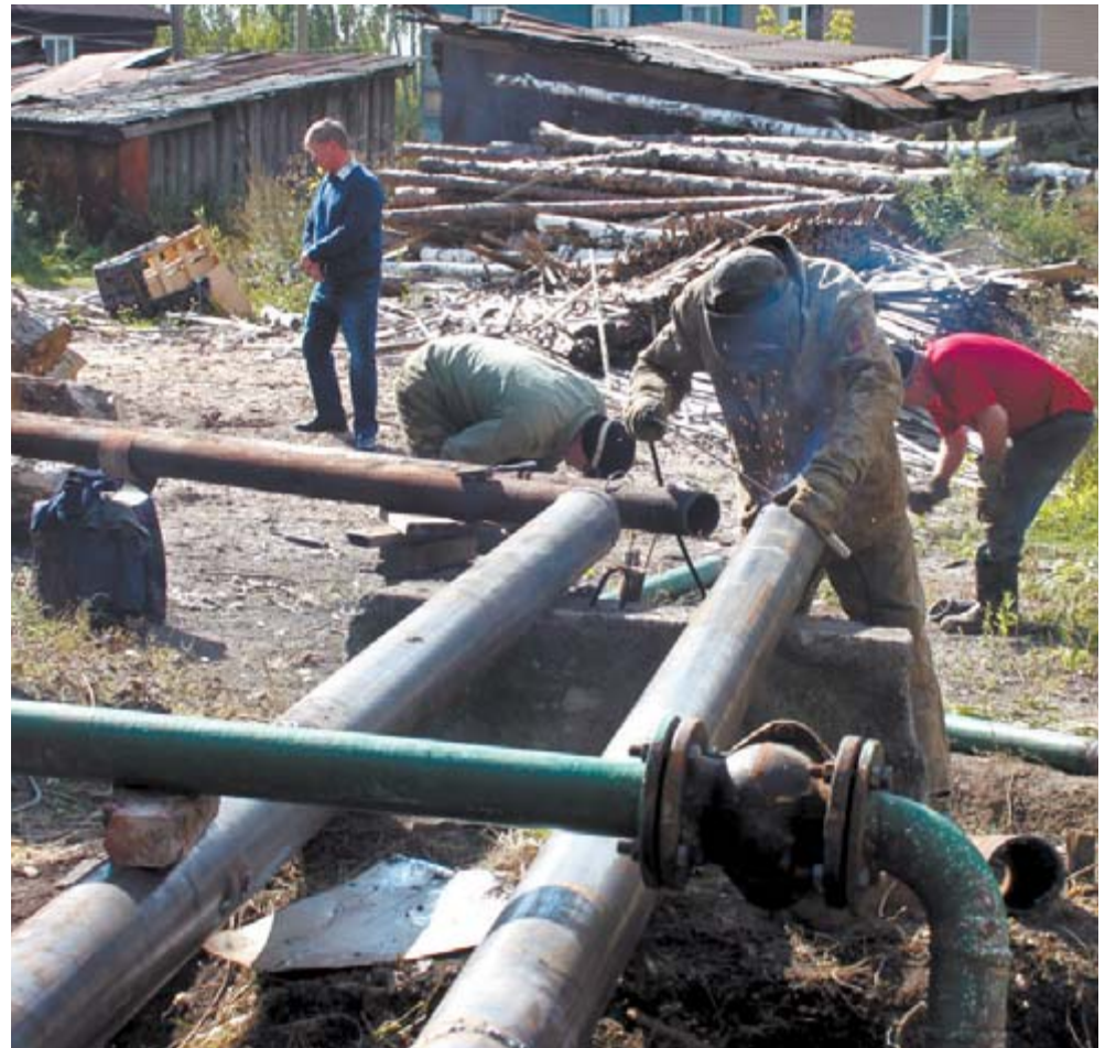
Идут работы по присоединению существующих теплосетей к новой строящейся теплотрассе
