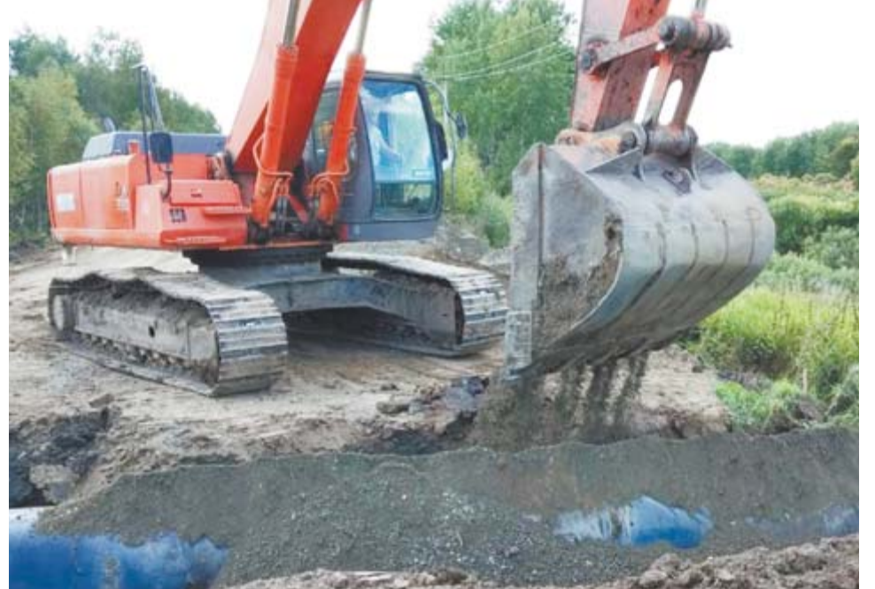
Идёт укладка новой водопропускной трубы
