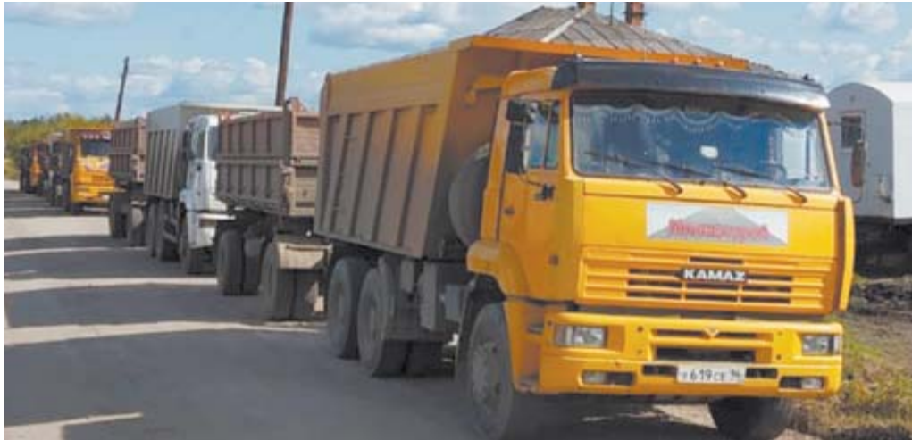
Завезли технику и стройматериалы
