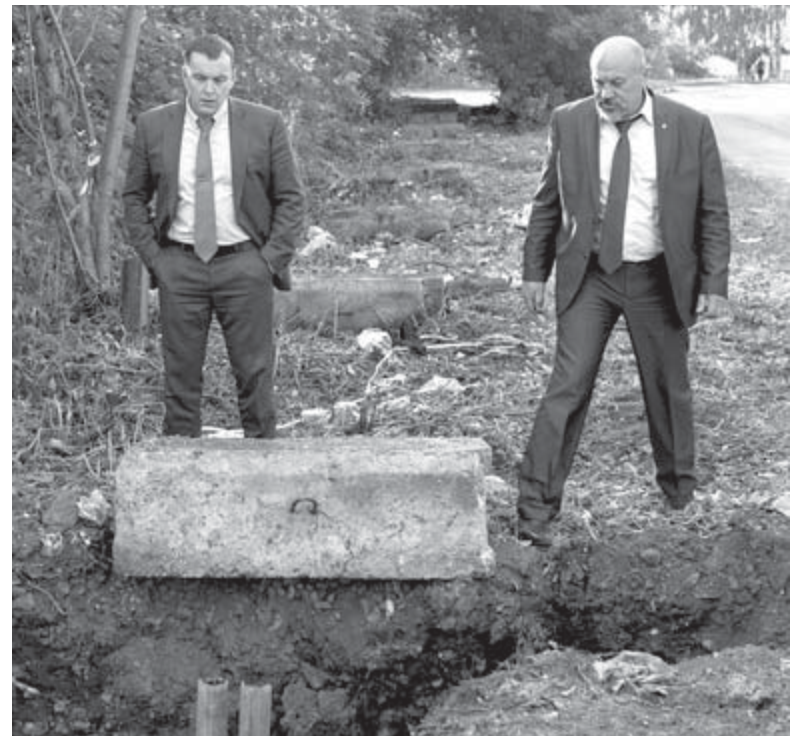
С. Беспалов и А. Шаньгин на осмотре теплосетей
