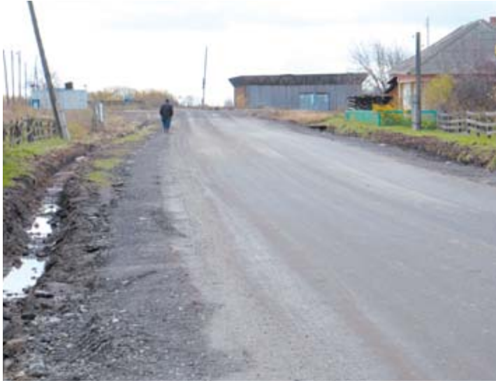
Новая дорога в с. Невьянском по ул. Свердлова
