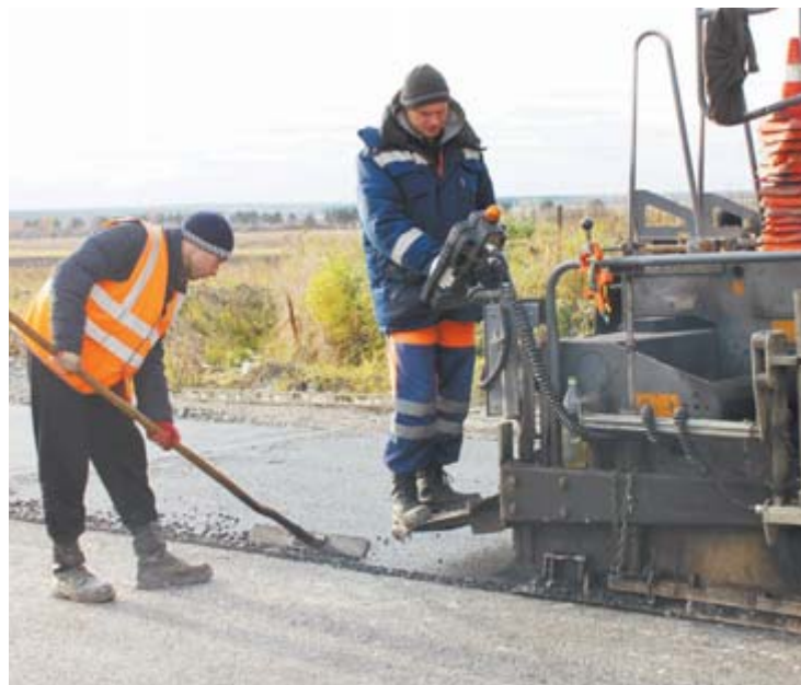
Идет укладка асфальта
