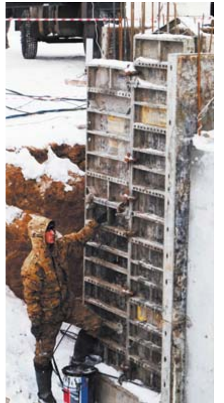
Идет монтаж опалубки
