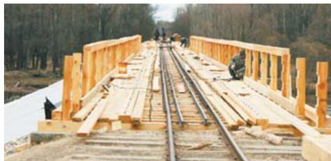
Новый мост на реке Туре
