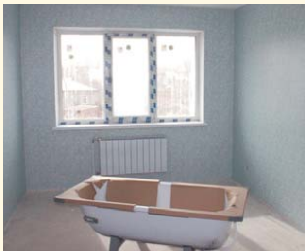
В квартирах устанавливают сантехнику
