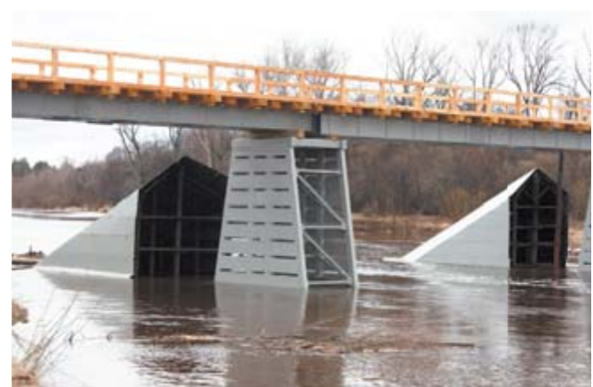
Испытание ледоходом мост выдержал
