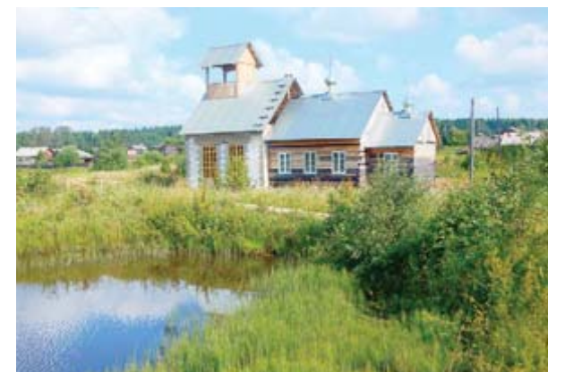
■ 2018 год. Теперь здание обрело вид храма
