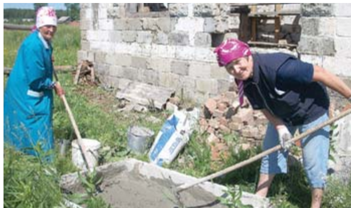
■ На стройке работали даже женщины
