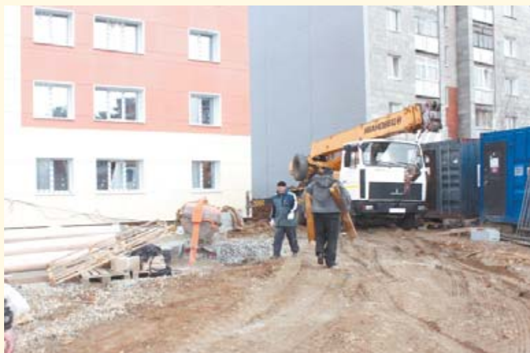
Строители приступают к благоустройству придомовой территории
