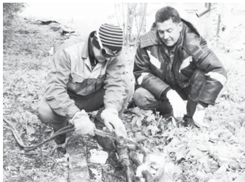
Сотрудники МУП «Энерготепло» ведут плановый ремонт теплосетей
