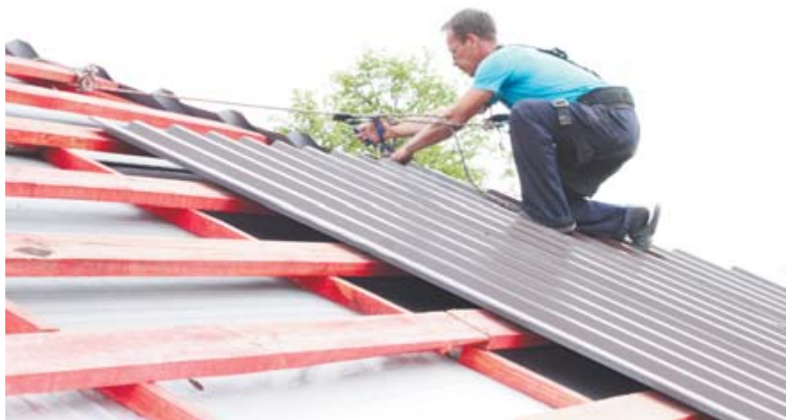
Ремонт кровли дома № 60 по улице Сафонова
