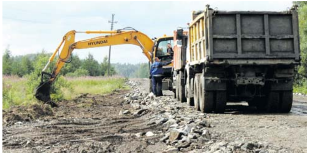
Рабочие на 121 км автодороги подбирают скальный грунт и планируют откосы
