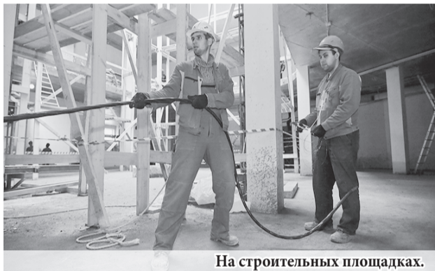
На строительных площадках.
