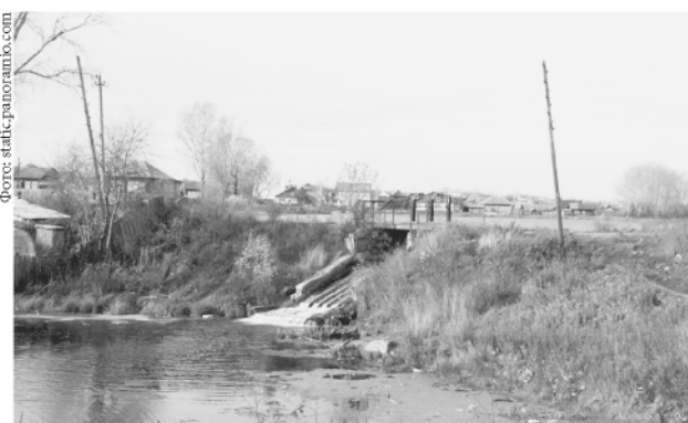
На реконструкцию ГТС Ачита потребуется 30 млн. рублей
