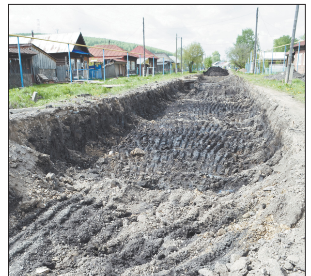
Выемка грунта – больше метра глубиной
