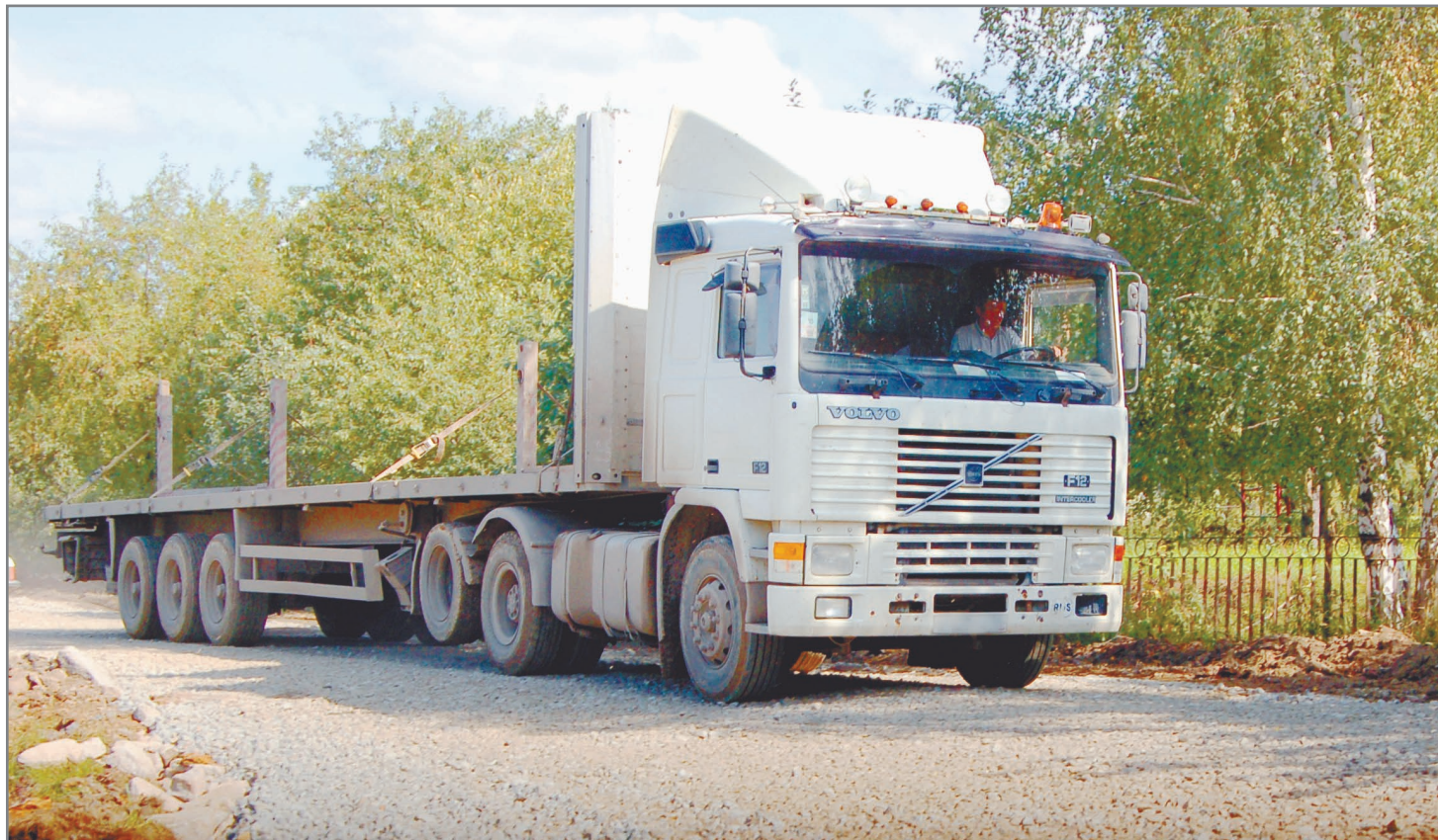
После ремонта дороги движение в Кедровке снова открыто!
