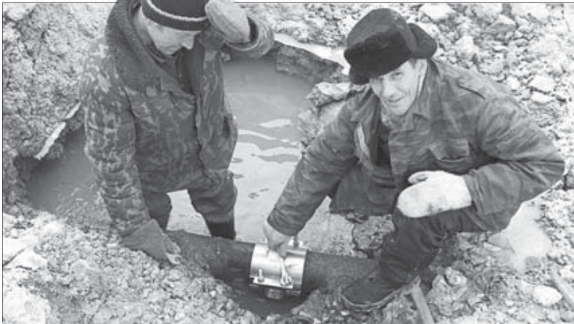
Чтобы наложить хомут, квалифицированным слесарям Владимиру Сукаленко (справа) и Владимиру Маркину понадобилось не больше пяти минут.
