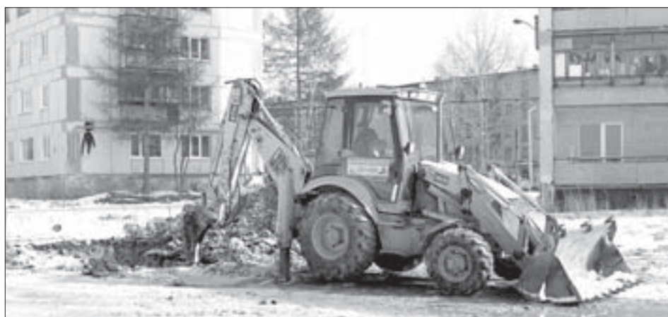
Выемка мёрзлого грунта возможна только с использованием гидромолота.
