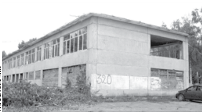
Сегодня на улице Победы полным ходом идет капитальный ремонт здания бывшего детского сада № 48. Возвращение в строй этого детского учреждения планируется в конце 2013 года.
