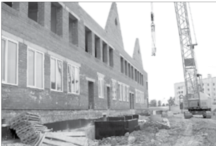
На строительстве детского сада в микрорайоне Центральный заканчивается стадия установки пластиковых окон
