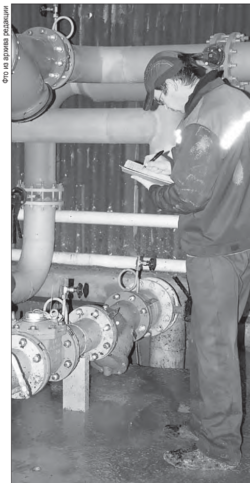
Министр энергетики и ЖКХ Свердловской области Николай Смирнов настоятельно рекомендовал компании «Новая энергетика» обеспечить подготовку котельной к отопительному сезону. Собственно, данная обязанность лежит на компании по закону
