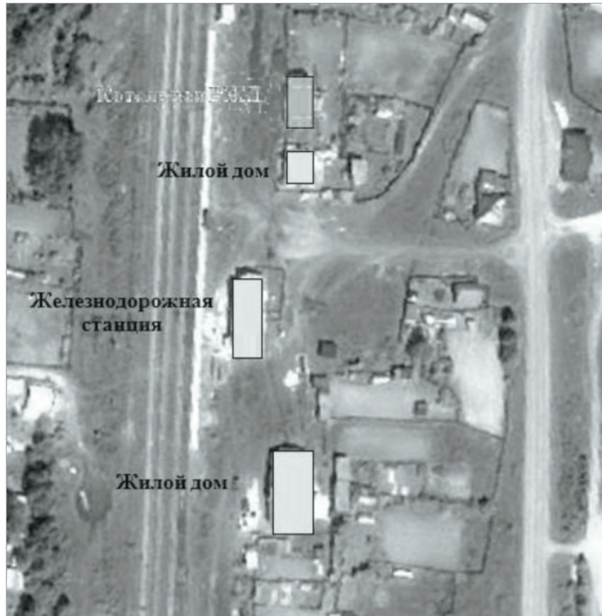
Рис. 6 Котельная ОАО «РЖД»
