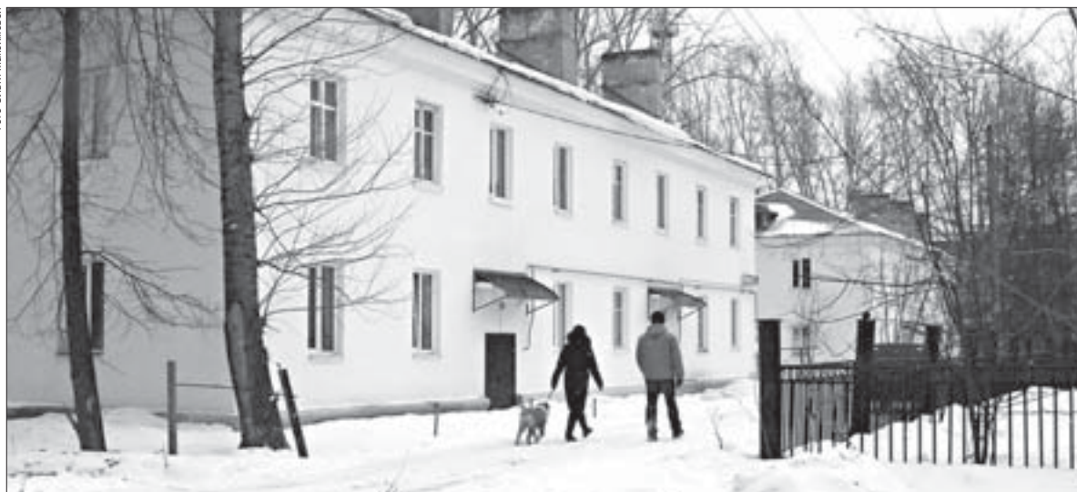
Из 20 домов, включённых в план капитальных ремонтов на 2015 год, на сегодняшний день полностью готовы два: Трояна, 1А и 3А. Работы там завершены, акты выполненных работ подписаны всеми сторонами
