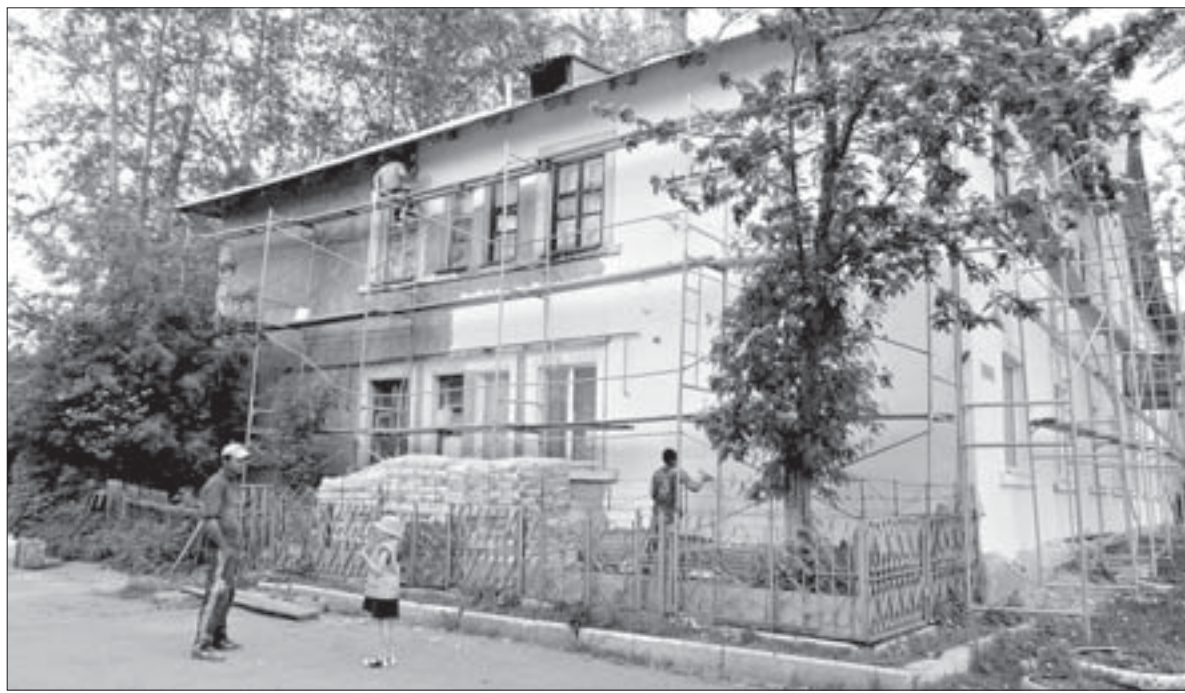
На фасадах домов по улице Свердлова полным ходом идут ремонтные работы
