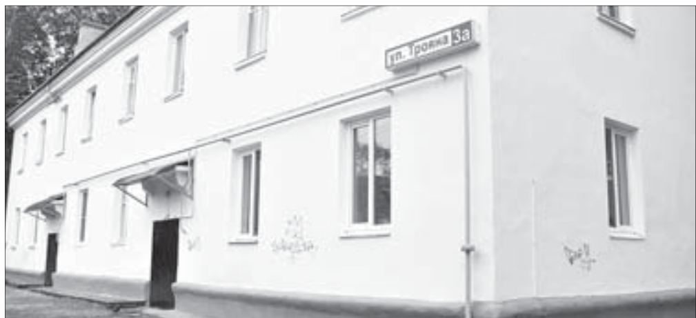
Дом по ул. Трояна, 3а – один из двух, где полностью окончен капитальный ремонт. Кому-то эта работа показалась незавершённой: он основательно прошёл вокруг здания и оставил везде свои художественные метки
