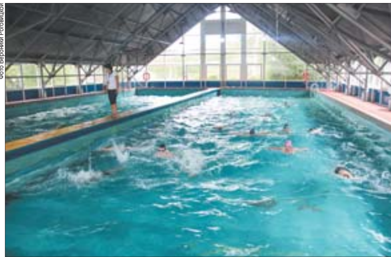
В бассейне установлены термометры для контроля за температурой воды и очистное оборудование. Занятия с детьми проводит квалифицированный инструктор
