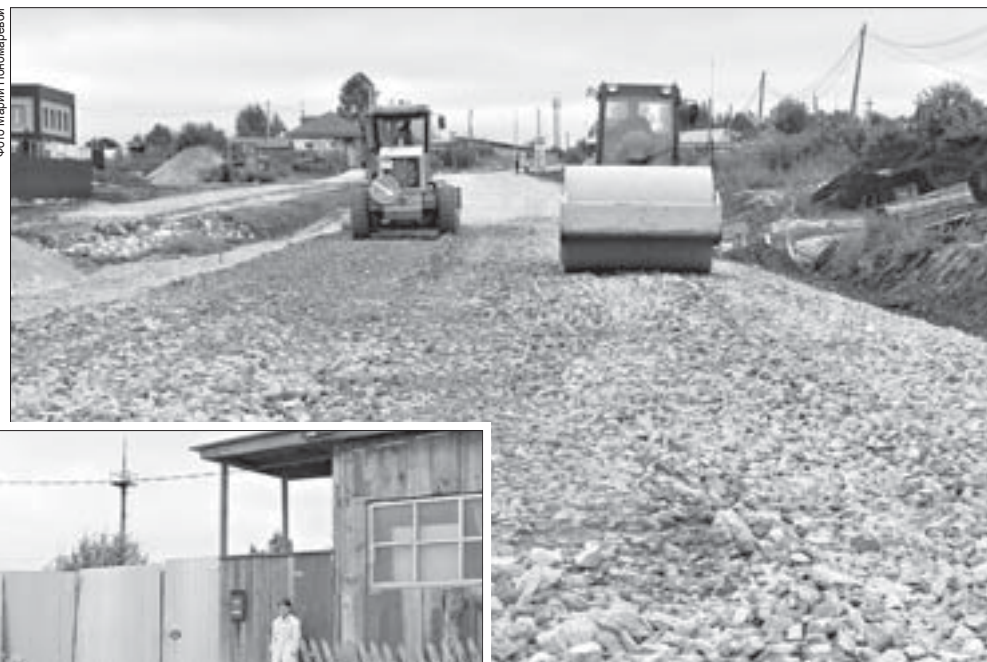
Четверть дороги, протяжённостью 2,5 километра уже отсыпана щебёночным основанием. Скоро будет укладываться асфальт
